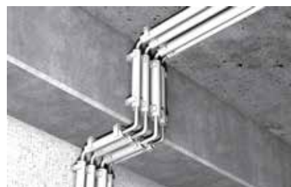
Befestigung von Kunststoff-Isolierrohren
