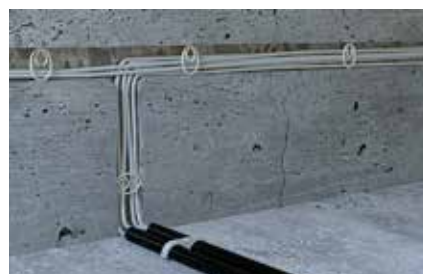
Kabelbefestigung in Wandschlitz < 55 mm
