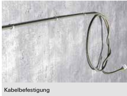
Befestigung flexibler Leerrohre
