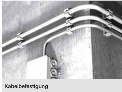
Befestigung von Kunststoff-Isolierrohren
