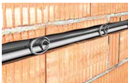
Kabelbefestigung in Wandschlitz > 30 mm
