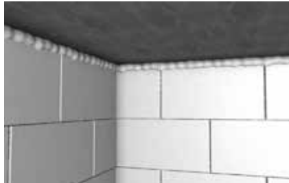
Dämmen und Füllen von Mauerdurchbrüchen
