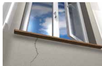
Schließen von Mauerwerksrissen im Innenbereich
