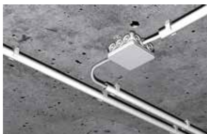
Befestigung von Kunststoff-Isolierrohren
