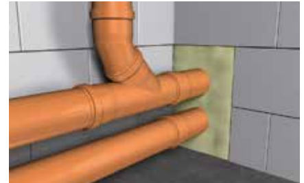
Füllen von Rohrdurchführungen
