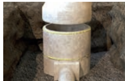
Abdichten von Beton-Schachtringen
