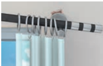
Reparatur ausgerissener Bohrlöcher
