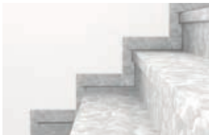
Verfugungen an Natursteinplatten
