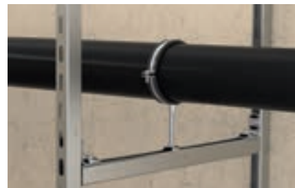
Rohrbefestigung auf Rahmenkonstruktion
