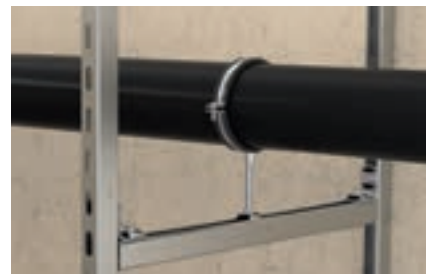
Rohrbefestigung auf Rahmenkonstruktion
