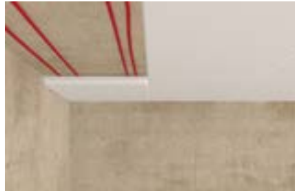
Dämmplatten an der Decke
