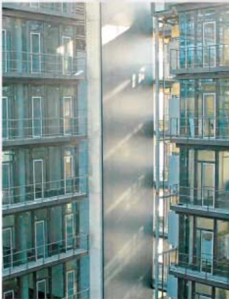
Der mit einer Glasfassade verkleidete Betonkörper (Mitte) verbindet die Gebäudeflügel.
